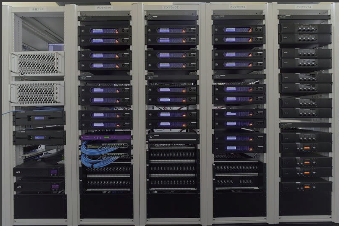
▲ 93 台のスピーカーを駆動するパワーアンプ「LINUS14」を収納したアンプラック
